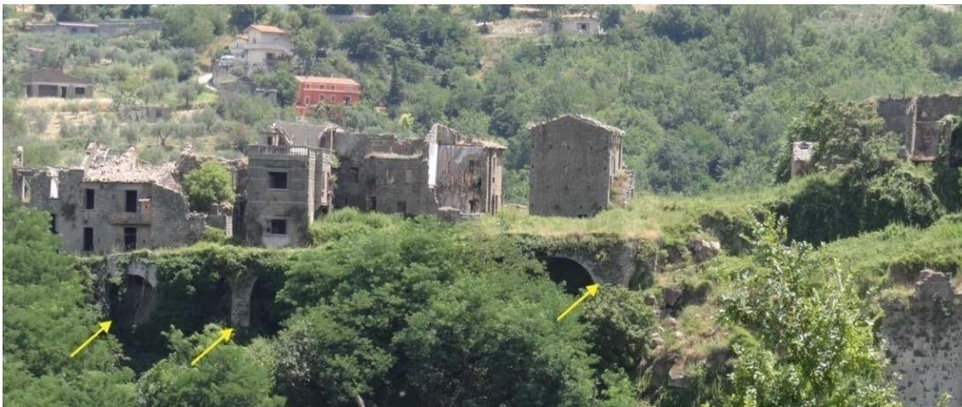
Tocco Caudio vecchia vista da nord: le frecce evidenziano i muri costruiti negli anni Venti del XX secolo per contrastare l'instabilità geologica del rilievo sul quale sorgeva l'abitato
